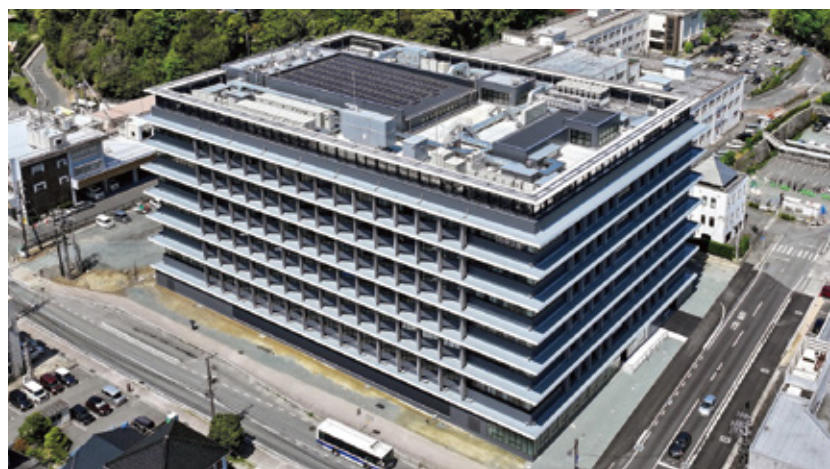
山口市新本庁舎と屋上の太陽光発電施設
