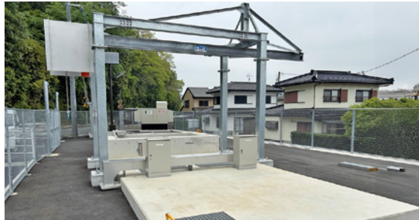
完成した問田雨水ポンプ場
