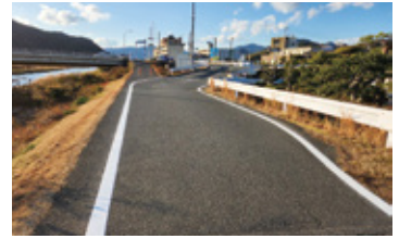
引き直しが完了した車道外側線(御堀橋付近)
