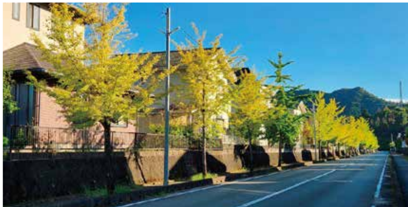
問田5号線(点検の結果異常なし) 10月4日撮影
