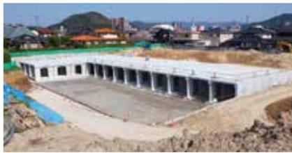
【イメージ写真】建設中の赤妻2号雨水貯留施設の様子(令和3年度完成)
