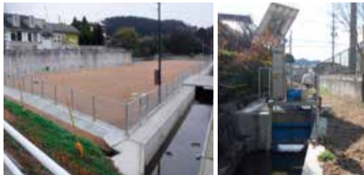
問田雨水貯留施設
