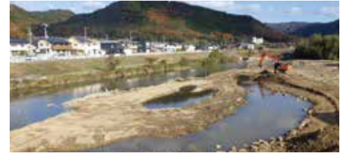
浚渫工事の様子(仁保川水上橋付近)
