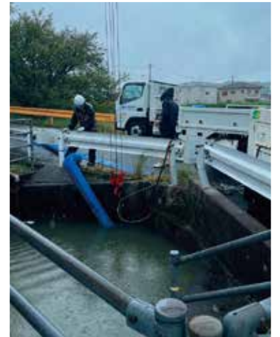
令和4年9月19日 排水ポンプでの緊急対応
