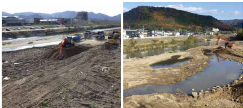
浚渫工事の様子 [左]榎野川(豊年橋付近) [右]仁保川(氷上橋付近)
